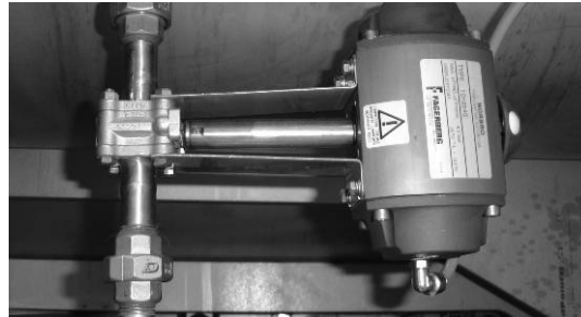
Abb. 6.4-12 Kugelventil mit Stellglied
