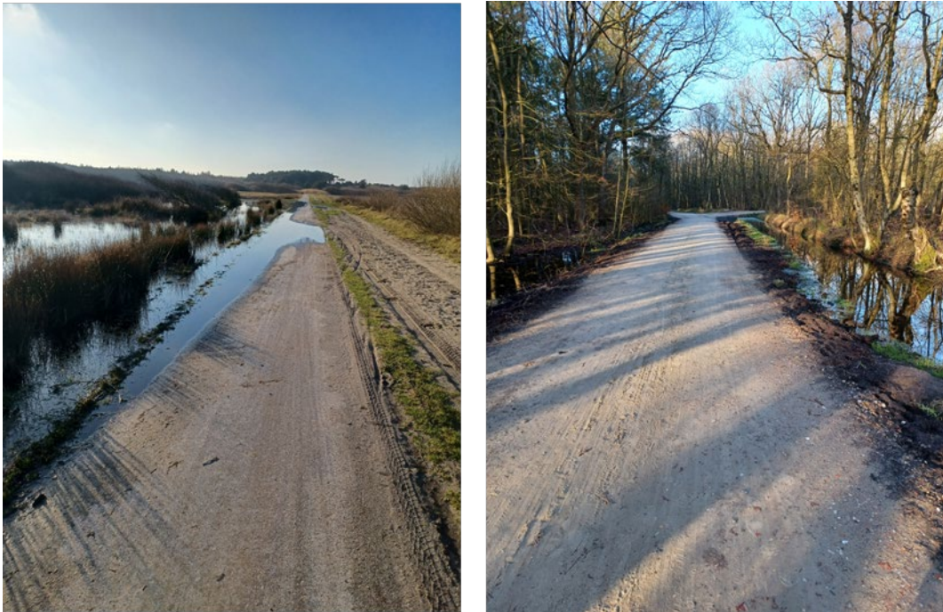
Figuur 3.1 - Links: ondergelopen fietspad nabij Hoorn januari 2025; Rechts: Uitgevoerde ophoging toegangspad nabij Kaap Hoorn.
